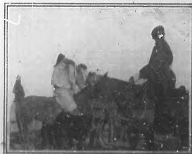
Un grupo de mongoles que prestaron eficaz ayuda a la construcción de la estación de Urga.
